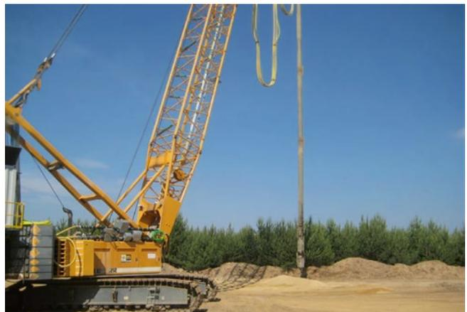
**Bild 3:** Rütteldruckverdichtung RDV
