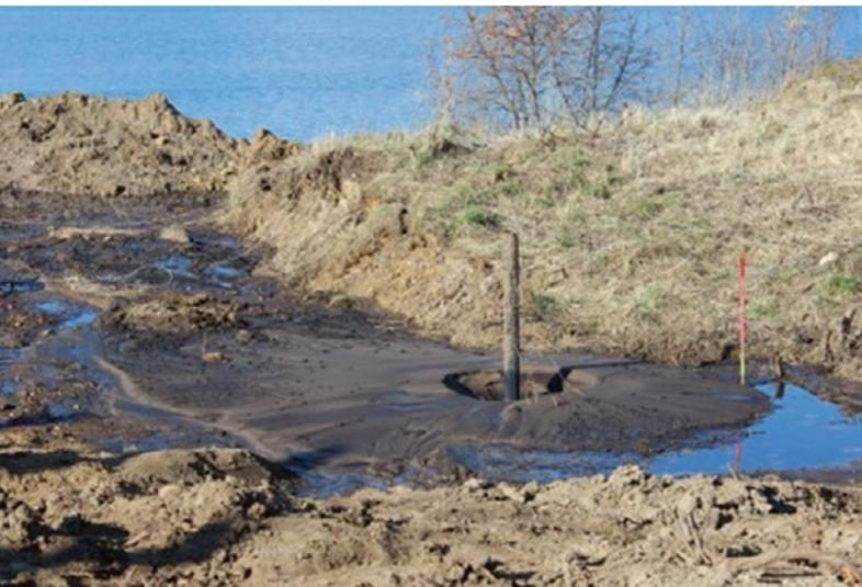
**Bild 4:** Schonende Sprengverdichtung
