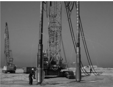
Bild 2: Tiefenverdichtung mit Tandem-Tiefenrüttler
