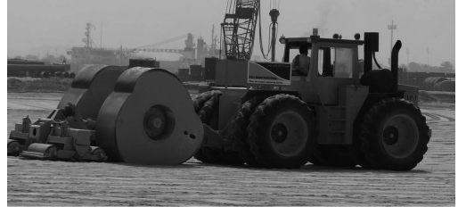
Bild 3: Oberflächenverdichtung mit dem „Landpac“
