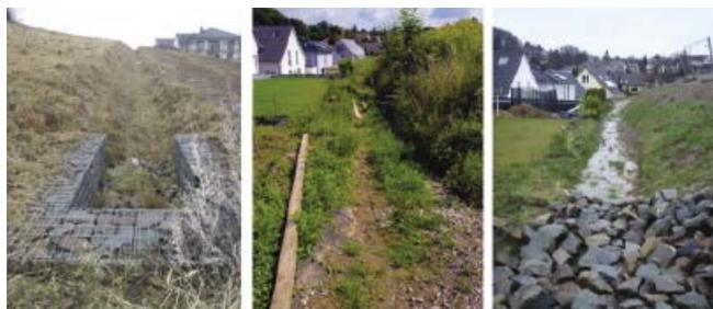
Abb. 6: Entwässerungsgraben – Zustand nach der Herstellung (links), Zwischenzustand (mitte) und Zustand nach der zweiten Wiederherstellung im Zuge der abschließenden Erschließungsarbeiten (rechts)
