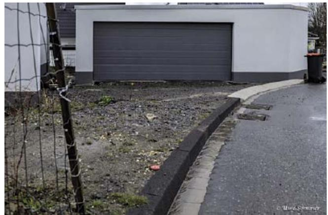
Abb. 8: Garageneinfahrt mit abgesenktem Hochbord (links), nachträglicher Umbau mit Schrägbord und zweitem Sinkkasten (rechts)
