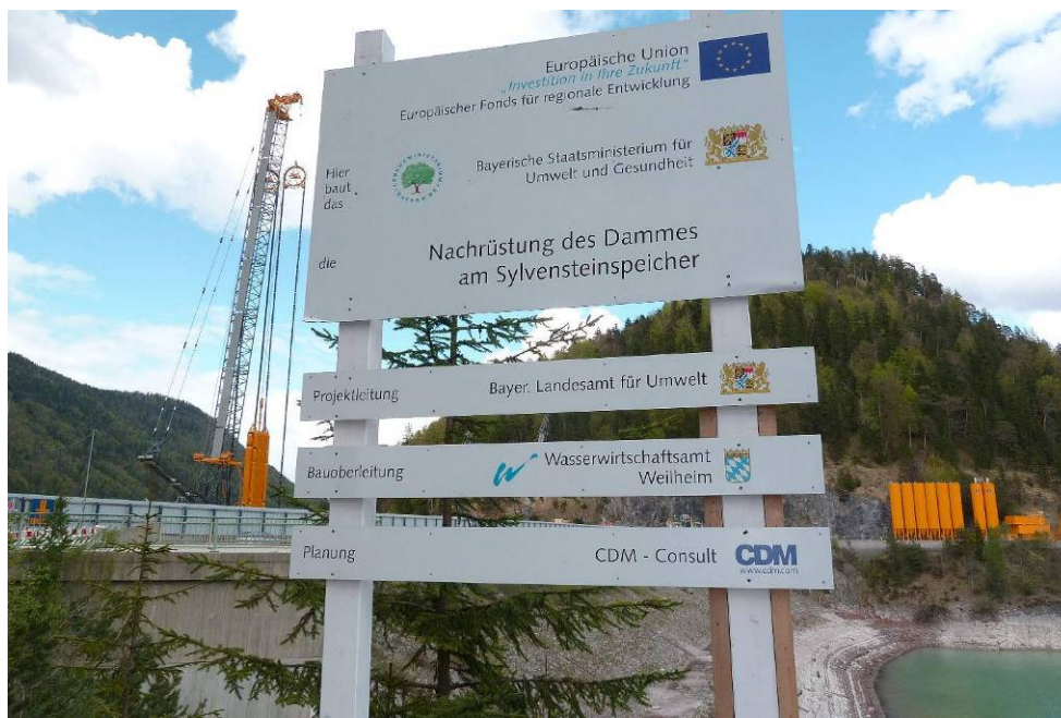
Abbildung 1: Bauschild zur laufenden Baumaßnahme zur Ertüchtigung des Sylvenstein Staudammes
