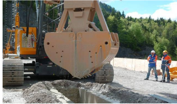
Abbildung 8 und 9: Fräse und Greifer zur Herstellung der 70 m tiefen Dichtwand
