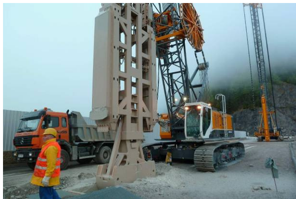
Abbildung 10 und 11: Laufender 24 h Baubetrieb, Greifern und Fräsen des Schlitzes, der mit Stützsuspension gefüllter ist.
