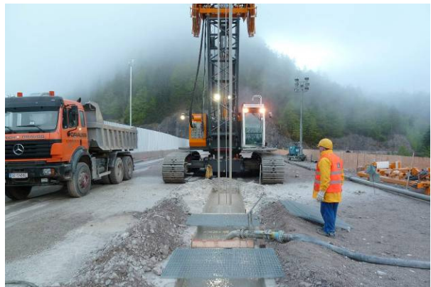
Abbildung 10 und 11: Laufender 24 h Baubetrieb, Greifern und Fräsen des Schlitzes, der mit Stützsuspension gefüllter ist.
