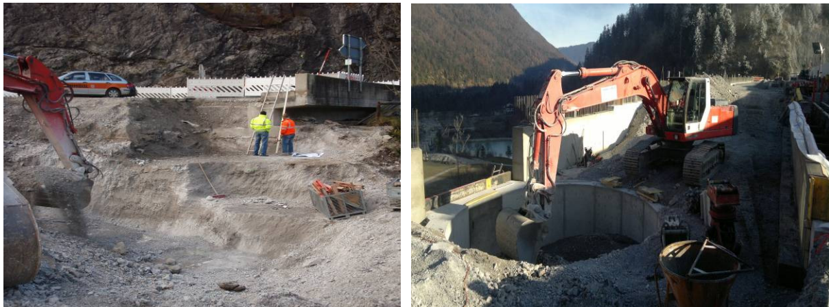
Abbildung 6 und 7: Freilegung der Felsoberfläche am Hennenköpfl und Errichtung des Kopfbauwerkes vom Zielschacht
