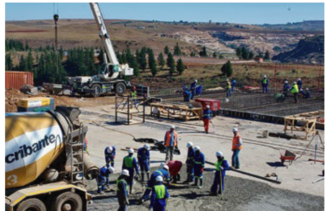
Proyecto Metalong Dam, suministro de agua
