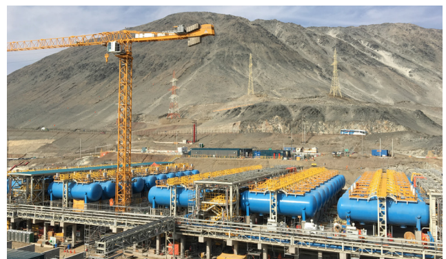
Escondida Water Supply Expansion, añadiendo 833 l/s Chile.
