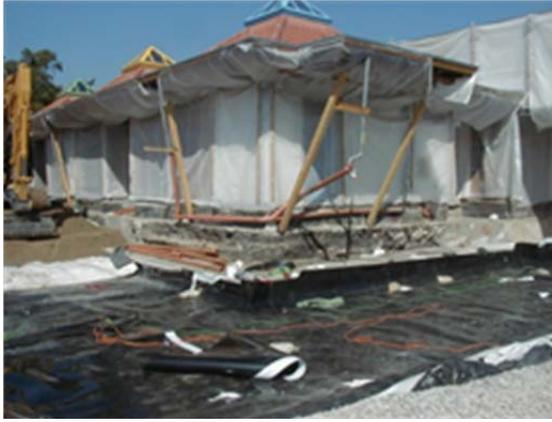
**Abbildung 4a: Einhäüllung Außenwände**
