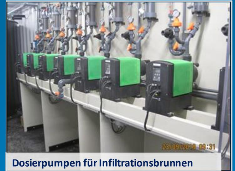
Dosierpumpen für Infiltrationsbrunnen
