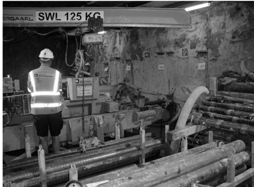
Abb. 10: Bohreinrichtung Injektionsbohrungen im Startschacht
