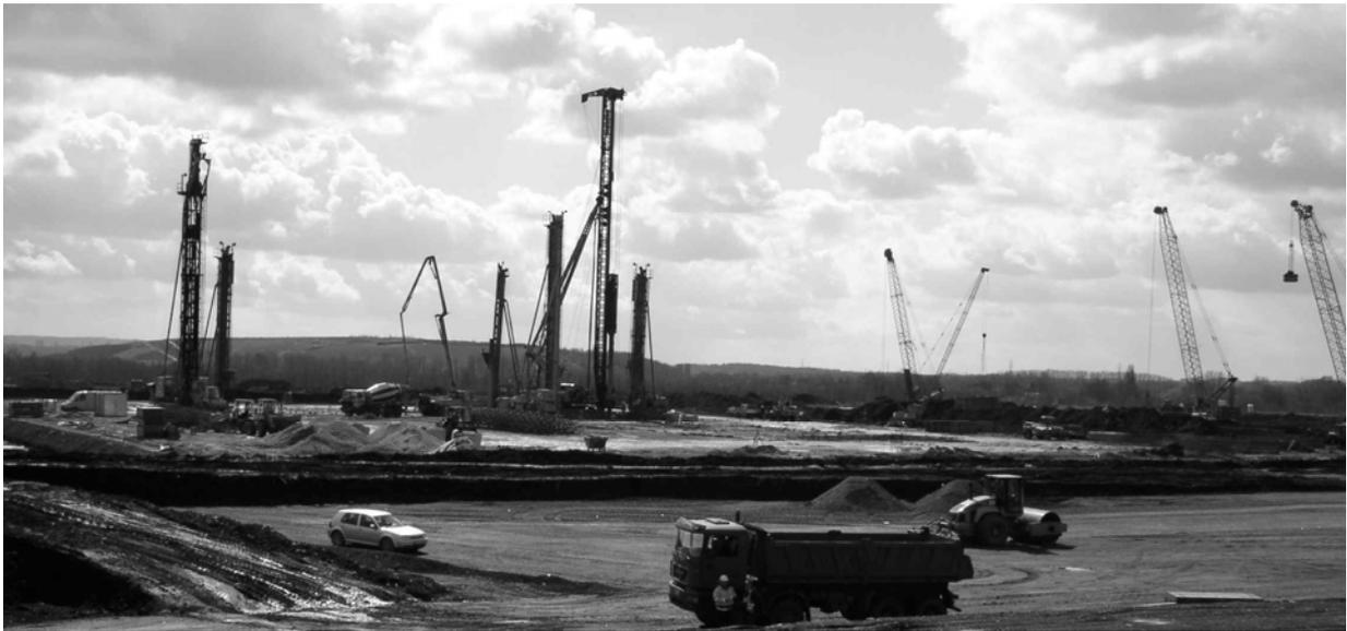
Abbildung 11: Pfahlarbeiten auf der Baufäche „ELF 1“ (links), Fallplattenverdichtungen im Baufeld „ELF 2“ (rechts)
