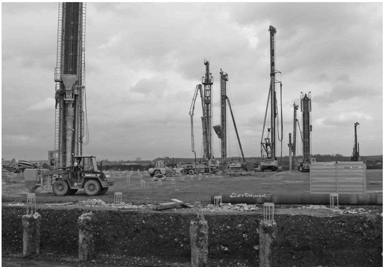
Abbildung 14: Herstellung der Pfähle mit Kopf- und Fußrammen (Einsatz Kopframmgeräte nur zur Vorrammung); im Vordergrund fertiggestellte Pfahlköpfe
