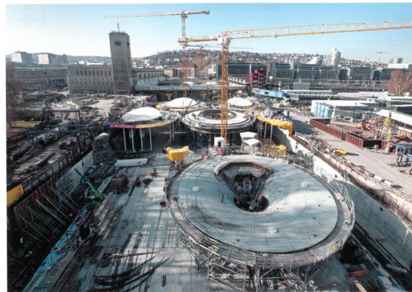
Bild 19: Blick in Bahnhofstrog mit Schalung Kelchstütze im Vordergrund
