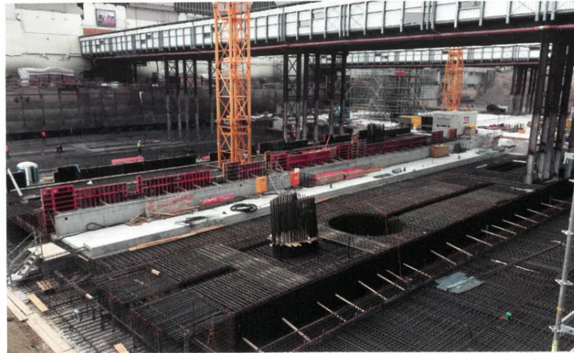
Bild 18: Bewehrung Bodenplatte mit Anschlussbewehrung Kelchstütze
