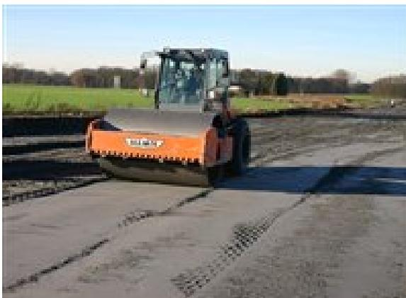
Abb. 8: Kraftwerksaschen als Konditionierungsmittel für pastöse Abfälle
