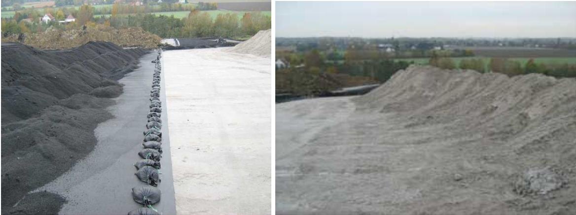
Abb. 1,2: Kunststoffdichtungsbahn auf Edelstahlschlacke 0/11 mm
