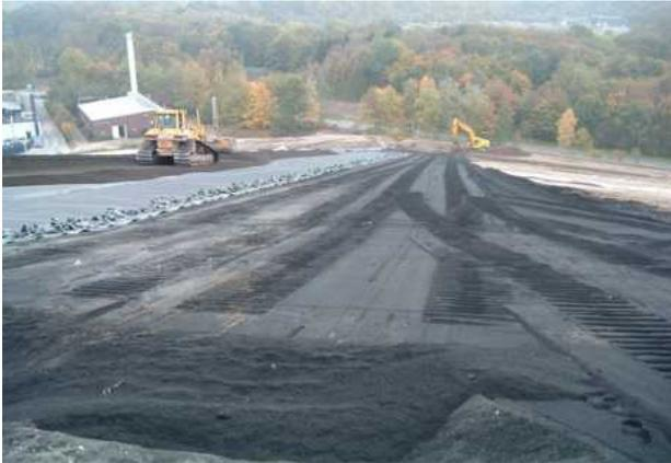
Abb. 9: Kapillarblock aus Schmelzkammergranulat
