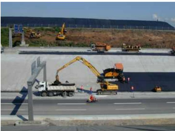
Abb. 5: Asphalttragschicht auf Edelstahlschlacke
