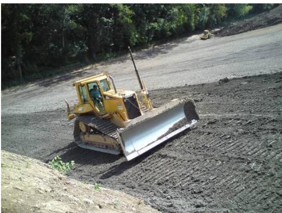
Abb. 11: mineralische Dichtung TREAmin®
