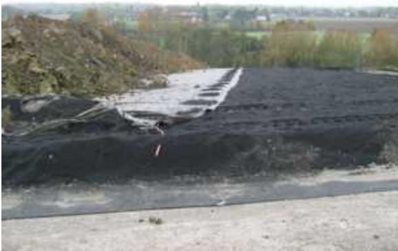
Abb. 12: Eisensilikatsand, Filtervlies, Rekultivierungsboden
