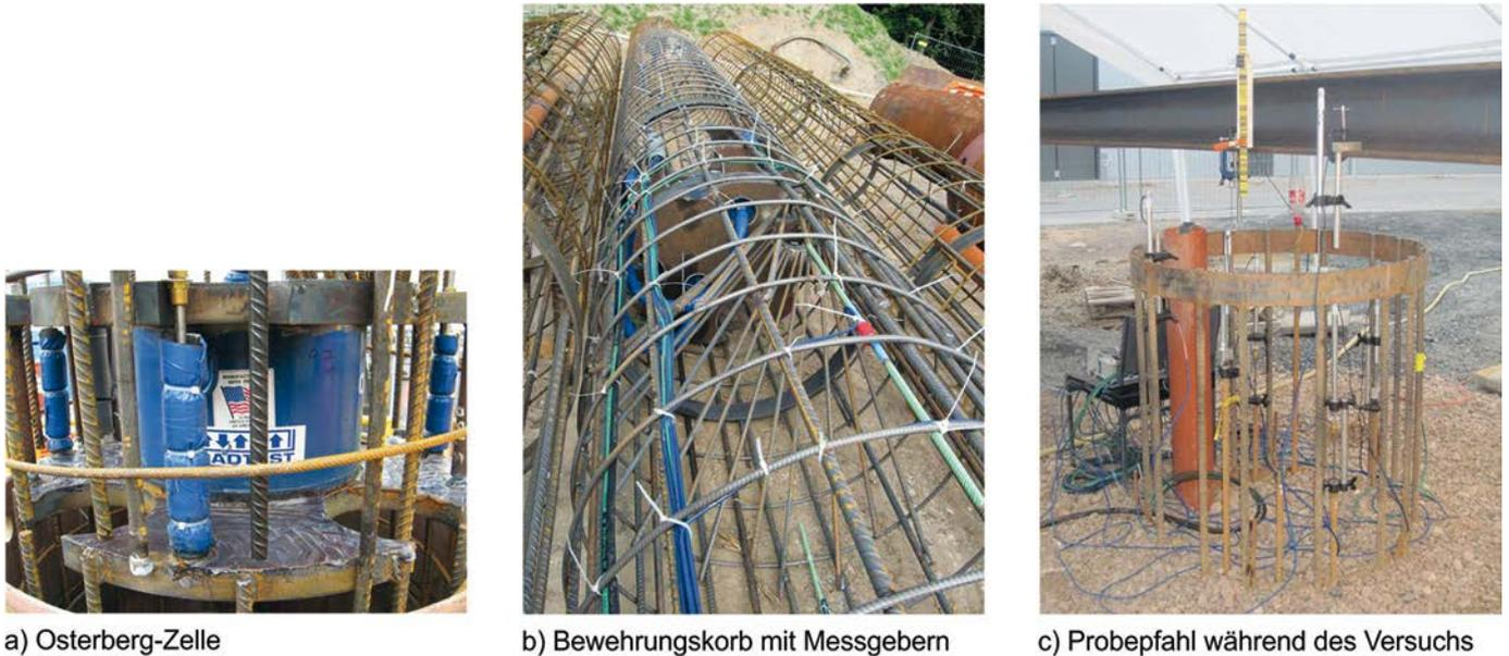
**Bild 4** Statische Pfahlprobelastungen nach dem Osterberg-Verfahren
