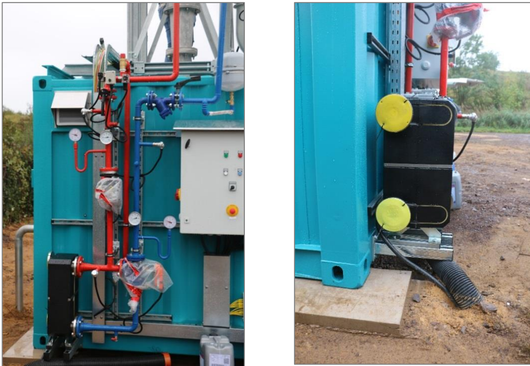
Abbildung 6: Schwachgasbehandlungsanlage mit Wärmeauskopplung
