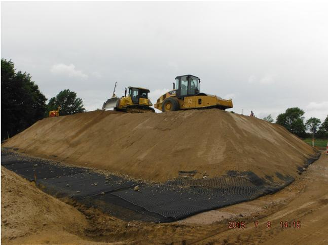
Bild 3: Belastungskörper zur Kontrolle des Setzungs- und Konsolidierungsverhaltens
