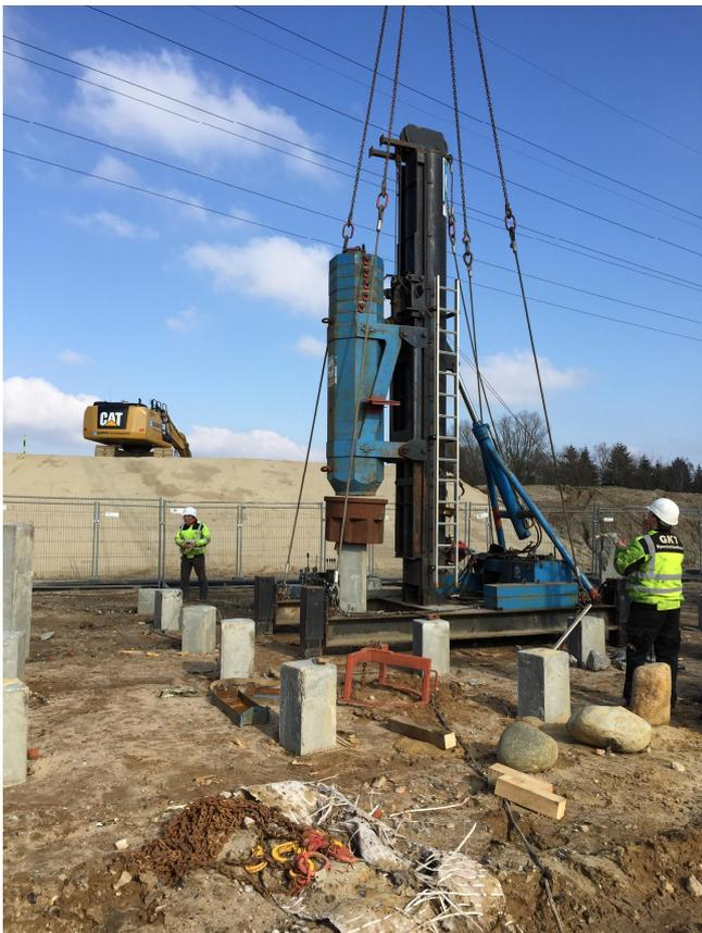
Bild 6: Dynamische Pfahlprobelastung
