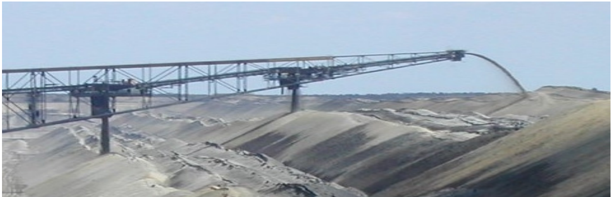
Abbildung 6: AFB F60 im Tagebau Jänschwalde (Quelle: VEM)
