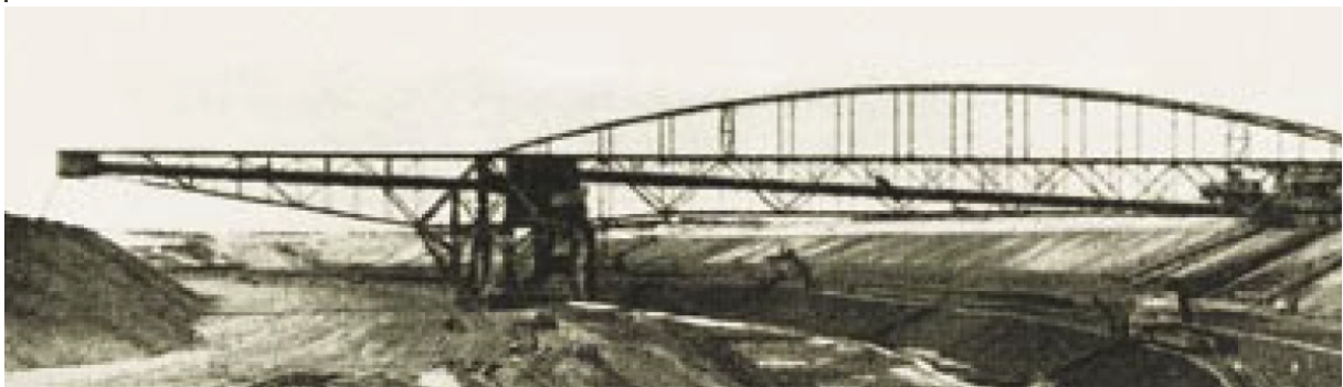
Abbildung 8: AFB Kleinleipisch Umbau 1938 (Quelle: LMBV, Wandlungen und Perspektiven)
