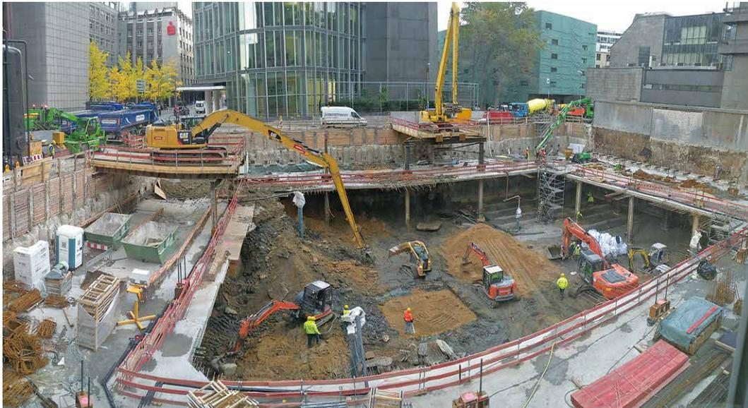
**Bild 8** Baugrubenaushub unterhalb des ersten Teildeckels
