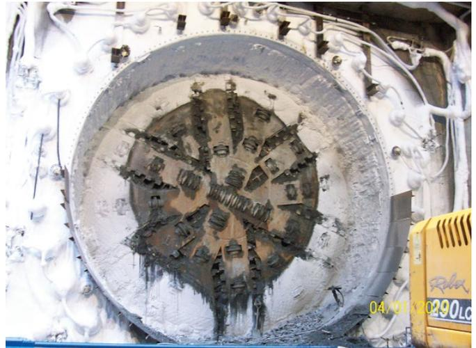
**Bild 1.** Marmaray-Projekt, Istanbul. Bodenvereisung zur Abdichtung eines havarierten Dichtblockes bei der Einfahrt der Tunnelvortriebsmaschine
