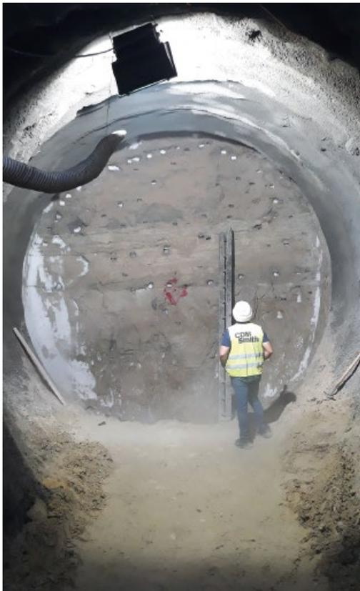
**Bild 4.** Gefrorener Boden in offenem Querschlag unter 4 bar Wasserdruck unter dem Suez-Kanal, Ägypten (Abbildungen: CDM Smith Consult GmbH)
